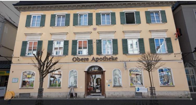
Abb. 5: Das Freistellrechteck steht nun auf den Ecken der Gebäudefront.
