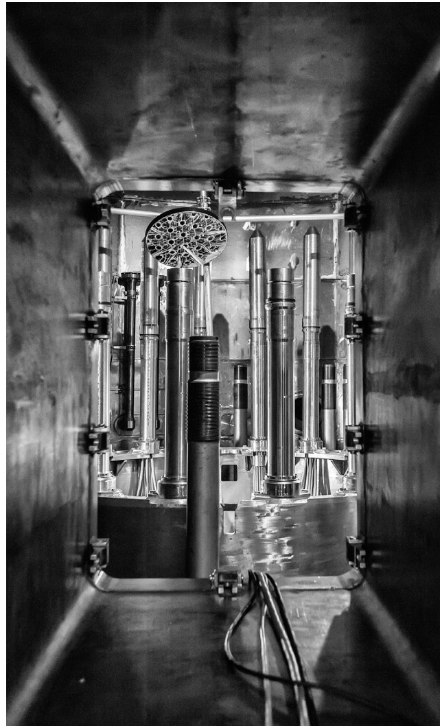
Abb. 2: Blick in den offenen Reaktorbehälter, der 42 Tonnen Kernbrennstoffe aufnehmen könnte. Der Spiegel links oben zeigt die Kassetten für Brennelemente.
