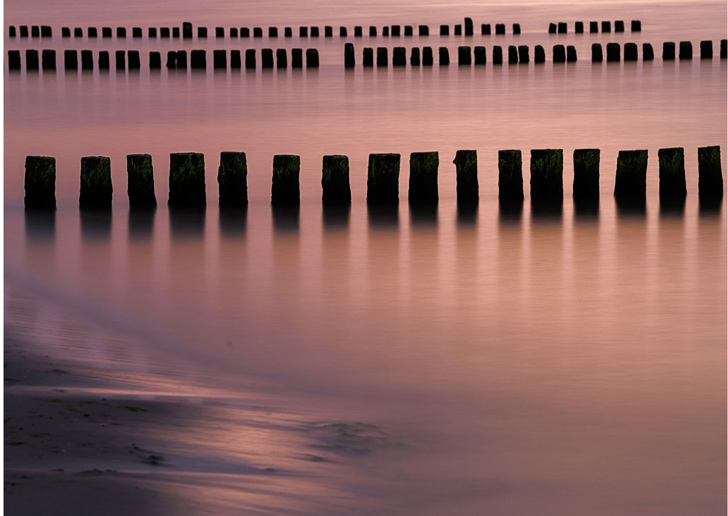
Abb. 12: Buhnen in der Abenddämmerung bei Koserow
