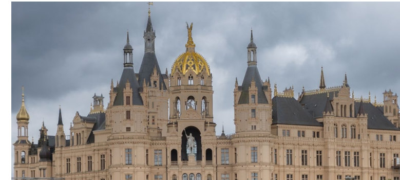
Abb. 10: Hier ist die Absenkung durch einen Verlaufsfiler per Bereichsmaske mit Luminanz auf die helleren Bereiche beschränkt
