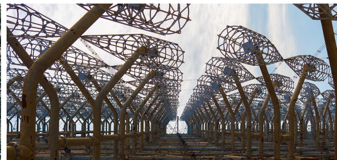
Abb. 8: Ein Blick von unten in die Antennen
