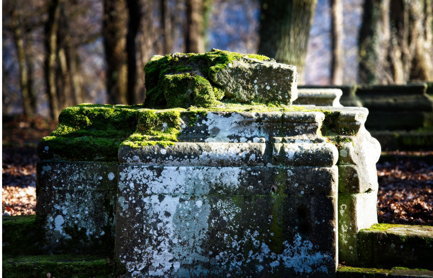
Abb. 2: Ruinenteil der Pfeilerbasilika
