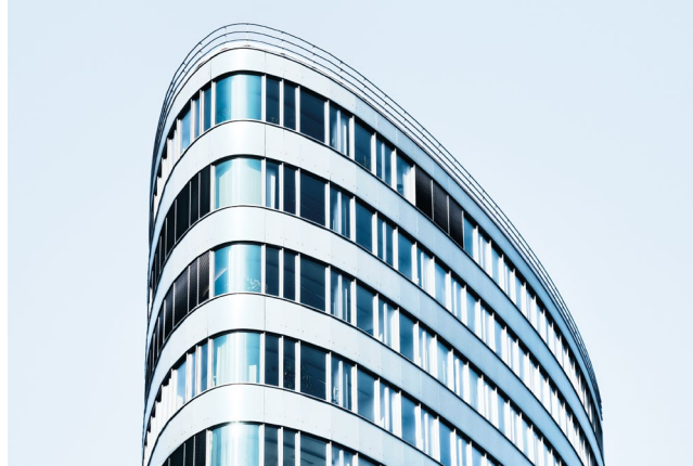
Abb. 5: Geringerer Abstand zum Gebäude, Bauwerk erscheint schlanker und spitzer [Bw.: 100 mm]
